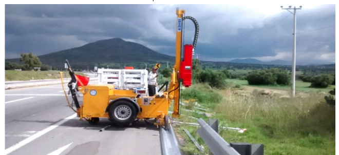
Contamos con Hincadoras de Postes para las instalaciones
